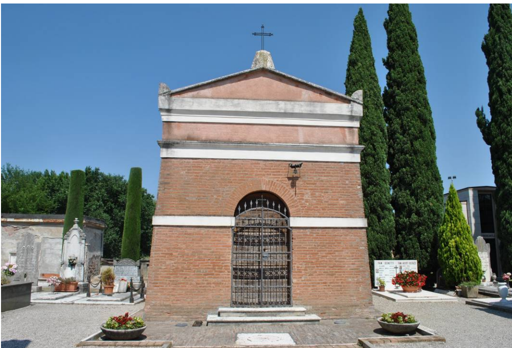
20. Vista della parte storica del plesso: la cappella di preghiera
