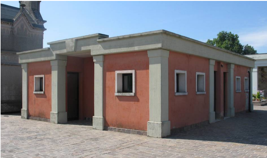
38. Zona sud ovest: blocco servizi di recente realizzazione.
