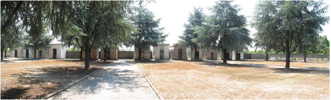
Immagine n°12: vista di parte del plesso caratterizzata da alberature a conifera.
