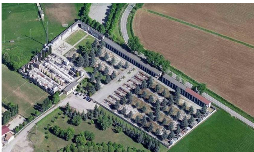
Immagine n°2b: foto aerea del camposanto. Il nord è in alto.
