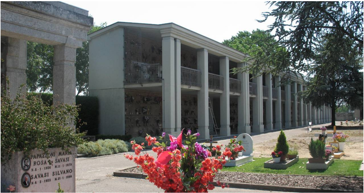
27. Zona nord est: galleria multi piano di recente realizzazione.
