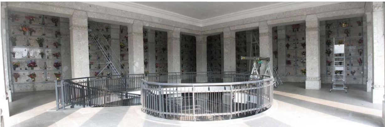
4. Vista dello scalone elicoidale di collegamento tra gallerie interrato e fuori terra (denominate: 2°, 3°, 4°, 5° e 6°).
