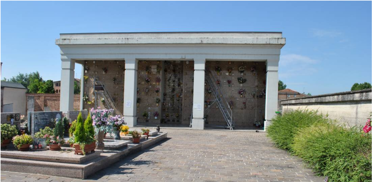
37. Zona sud ovest: galleria di recente realizzazione.
