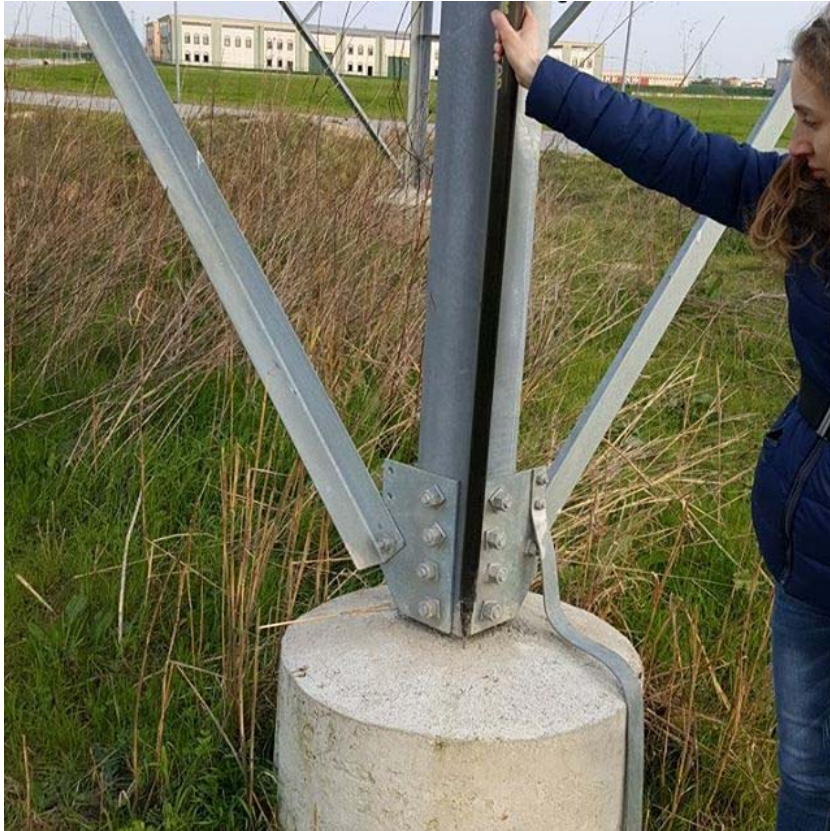
Figura A.6 – Caposaldo locale traliccio energia elettrica
