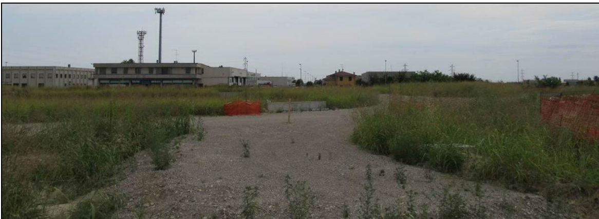
Figura 14 – Cantiere nuova bretella “Valdaro – casello Mantova Nord”
