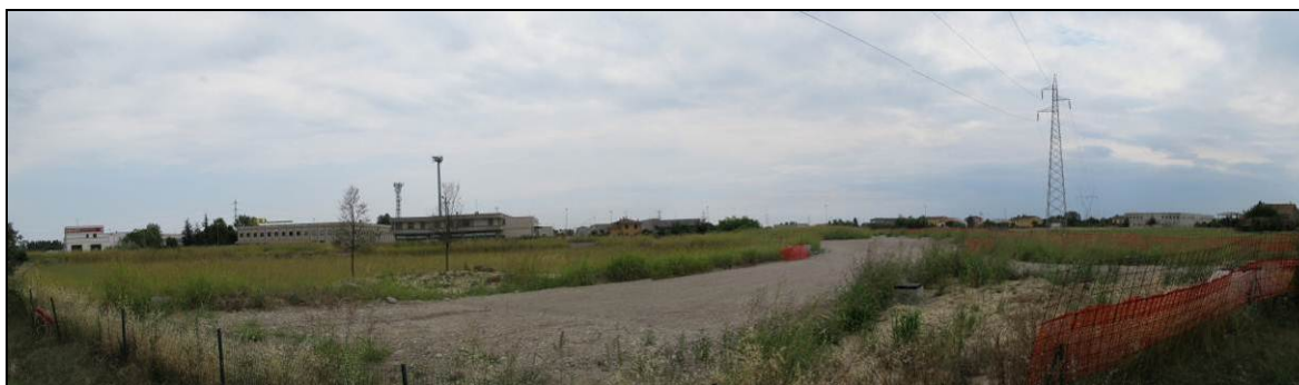
Figura 12 – Cantiere nuova bretella "Valdaro – casello Mantova Nord"
