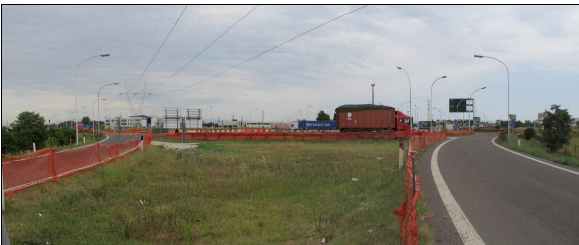
Figura 15 – Cantiere nuova bretella “Valdaro – casello Mantova Nord”
